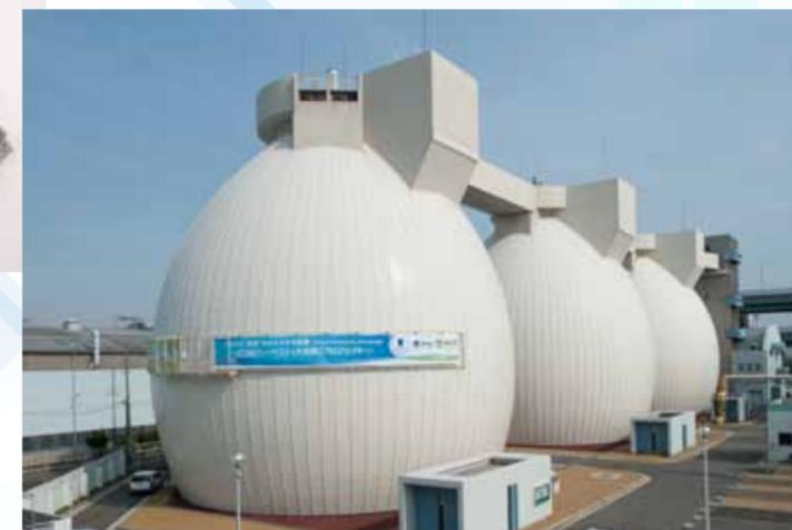
▲【写真2】消化汚泥からリンを回収します
