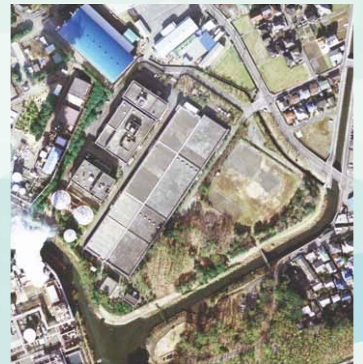
▲写真2 西部浄化センター水処理棟屋上 (10,476㎡)
