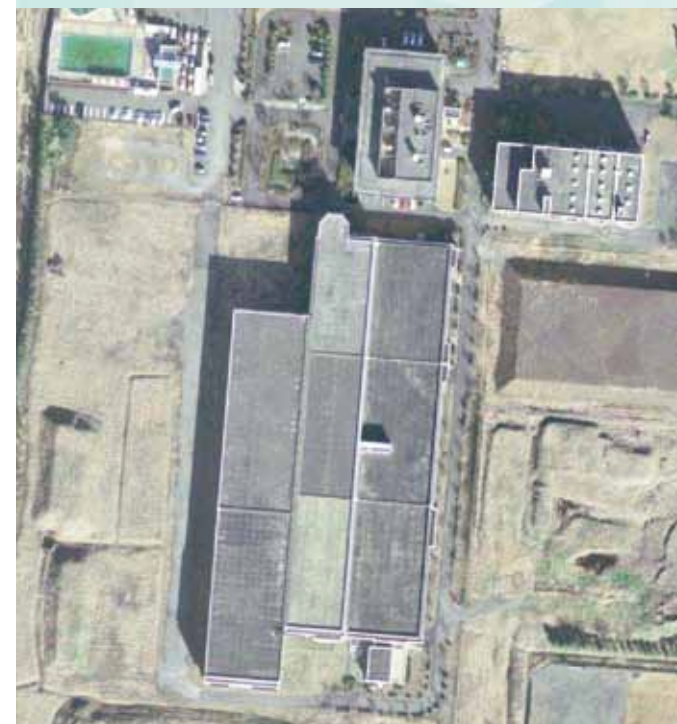
▲写真1 東部浄化センター水処理棟屋上 (11,331㎡)
